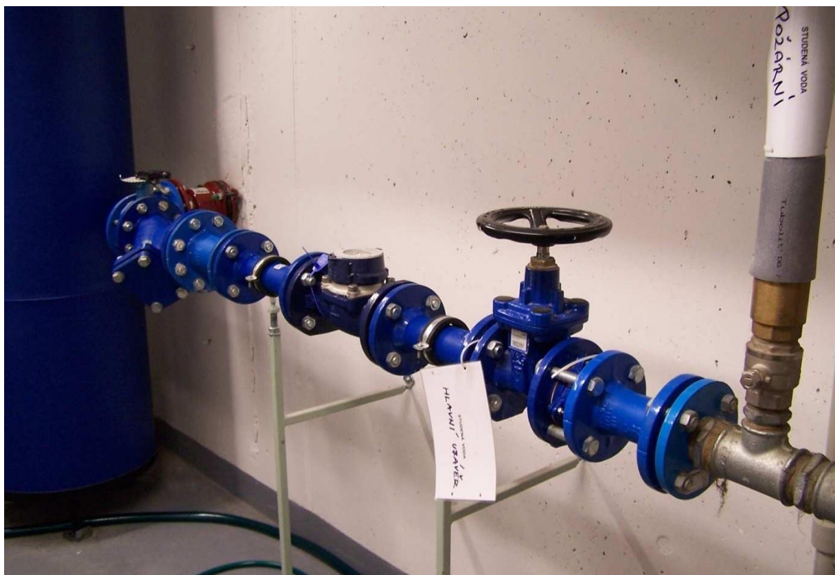
Obrázek: Vodoměrná sestava v 1.PP.
