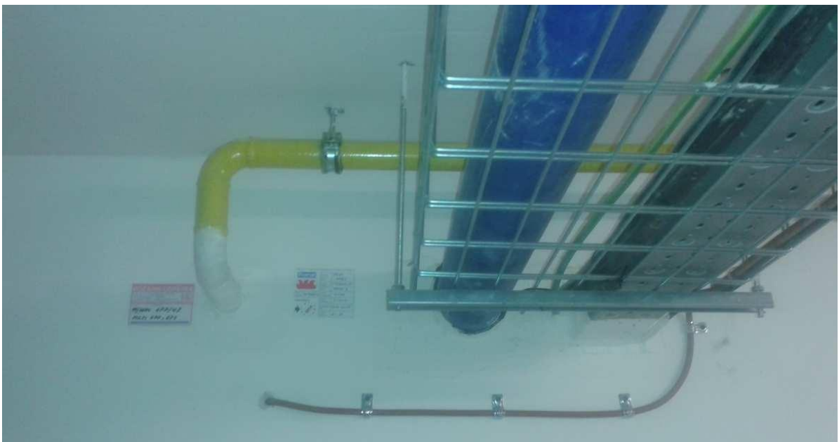
Obrázek: Požární ucpávka plynového potrubí v suterénu
