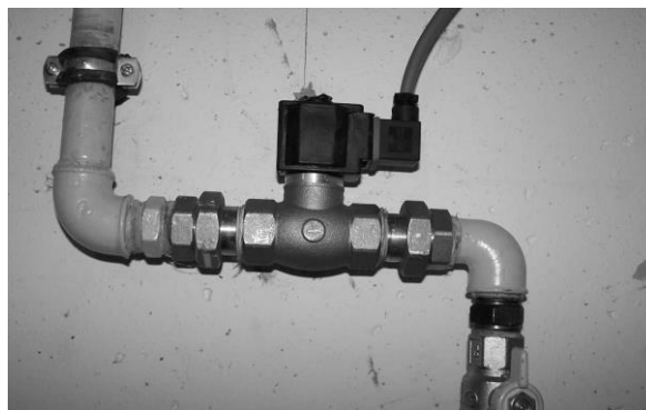
Obrázek: Tlačítkový hlásič na chráněné únikové cestě a uzávěr přívodu plynu systémem EPS
