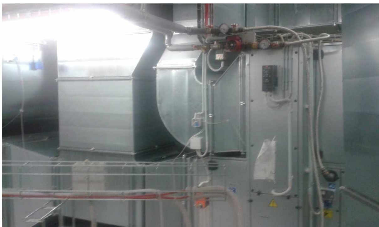
Obrázky: Strojovna vzduchotechniky
