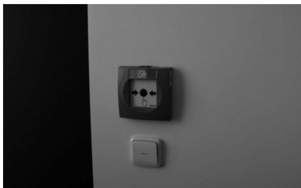
Obrázek: Tlačítkový hlásič na chráněné únikové cestě a uzávěr přívodu plynu systémem EPS
