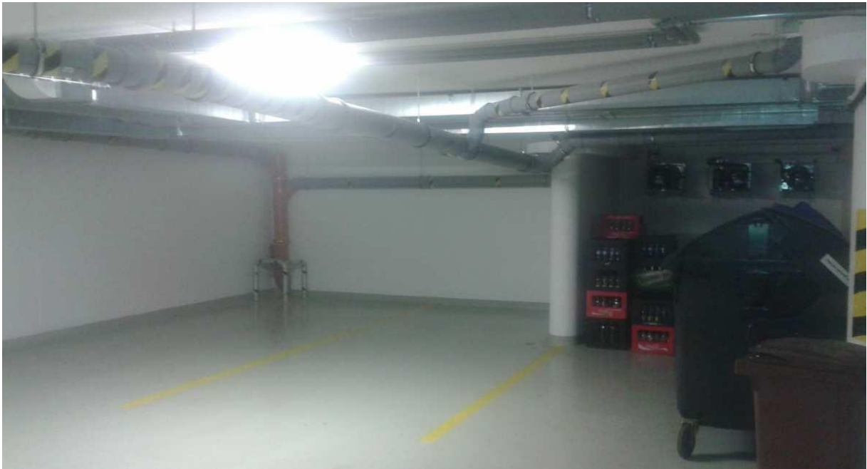
Obrázek: Rozvody kanalizace pod stropem 1.PP.
