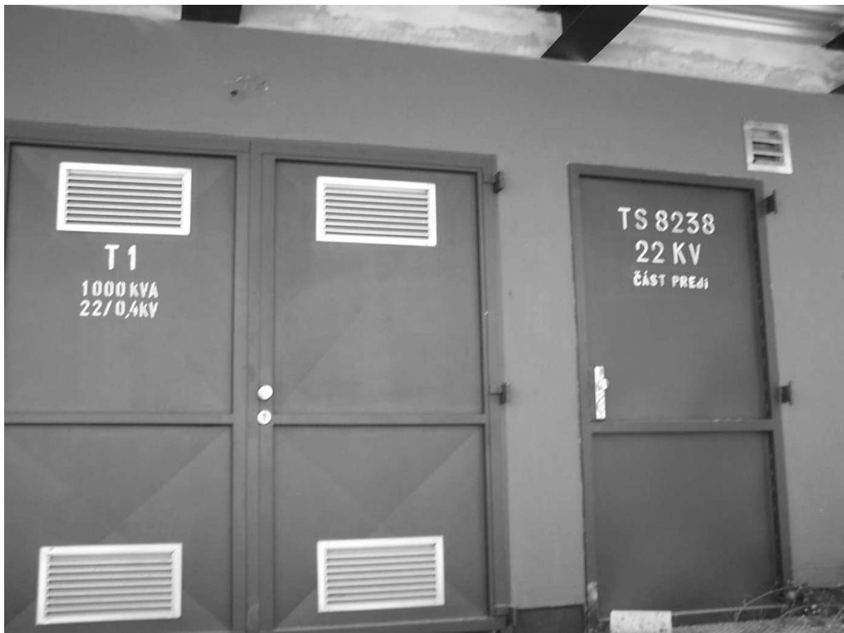
Obrázek: Přístup k trafostanici
