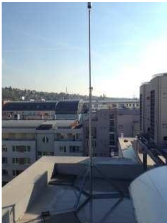
Obrázek: Hromosvod – jímací část
