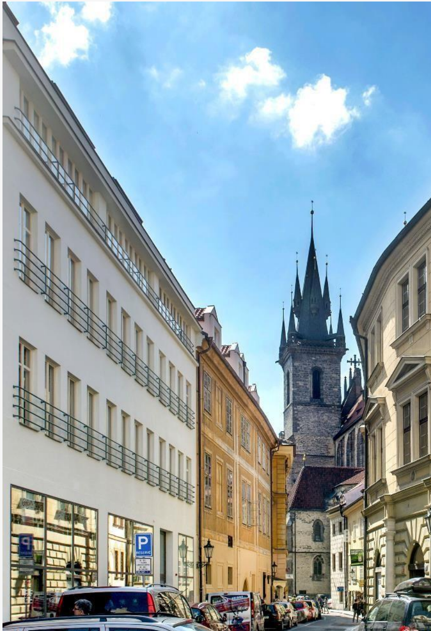
POHLED Z ULICE ŠTUPARTSKÁ
