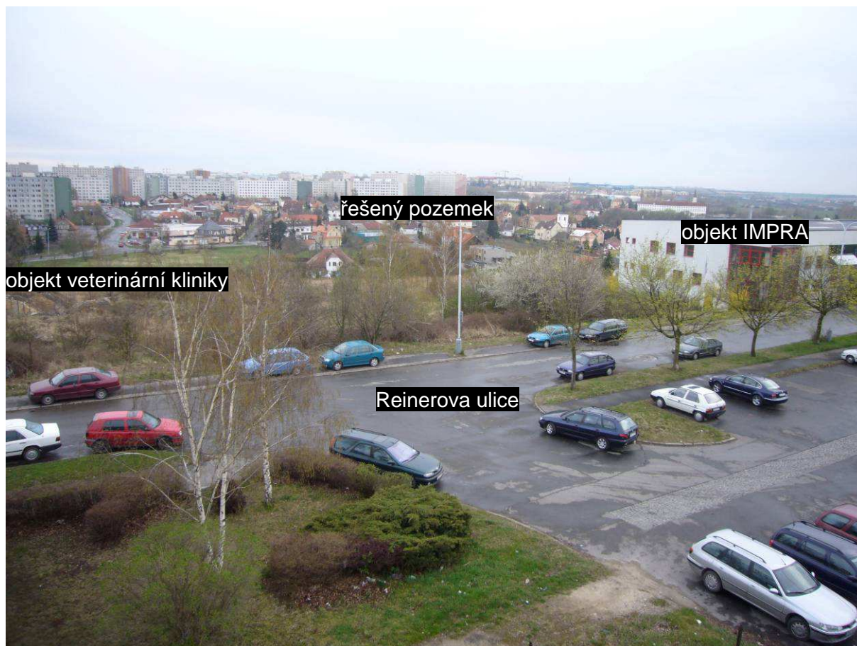
Foto stávajícího stavu – nahléd ze střechy protilehlého objektu v Reinerově ulici
